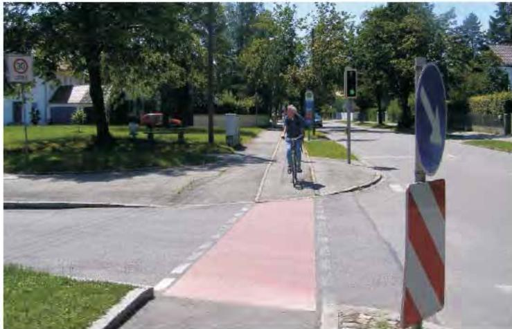
Beispiel für einen typischen verkehrstechnischen Ausbau an der Übergangsstelle Radweg-Straßeneinmündung
